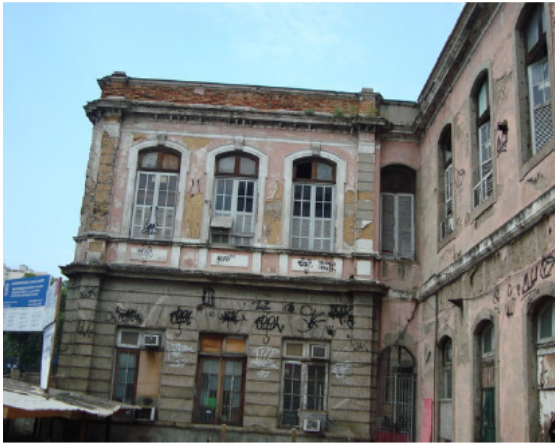
Fachada dos prédios 6 e 7
