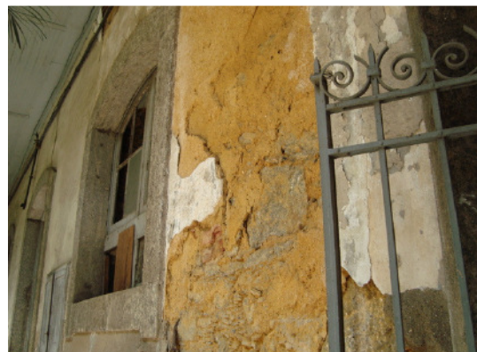
Fachada interna do prédio 3
