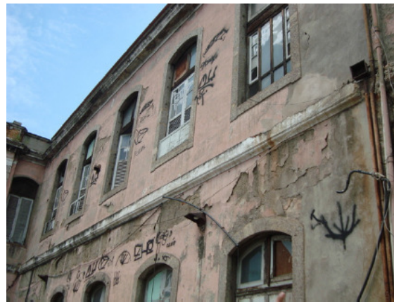
Fachada dos prédio 7
