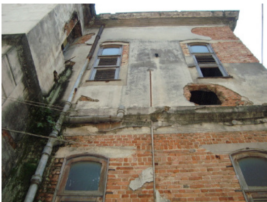
Fachada do prédio 1
