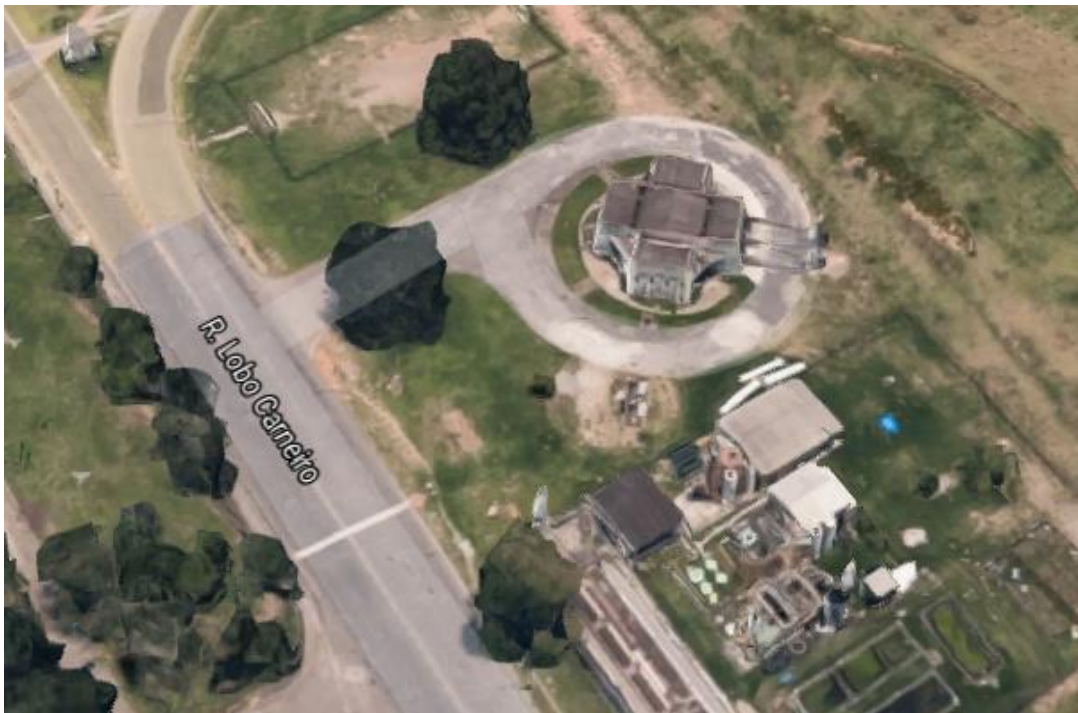
Figura 45: Estação elevatória de esgoto da CEDAE (-22.858848217527605, -43.23386933890033)
